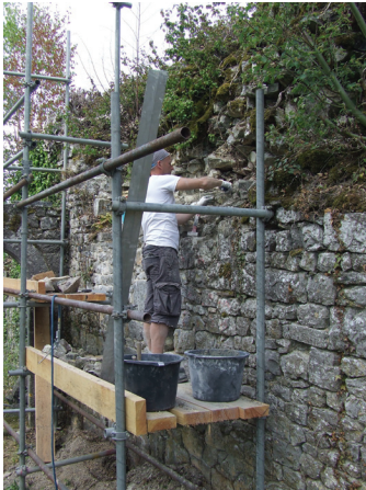
Stage de restauration à Poilvache, mai 2014 (photo © MPMM)
